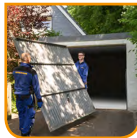
Ausbau und umweltgerechte Entsorgung
